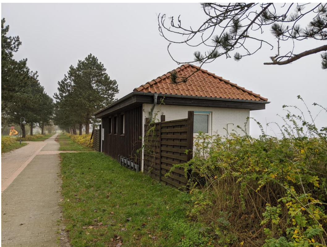
Abbildung 4: Strandpromenade im Bereich des Plangebietes
