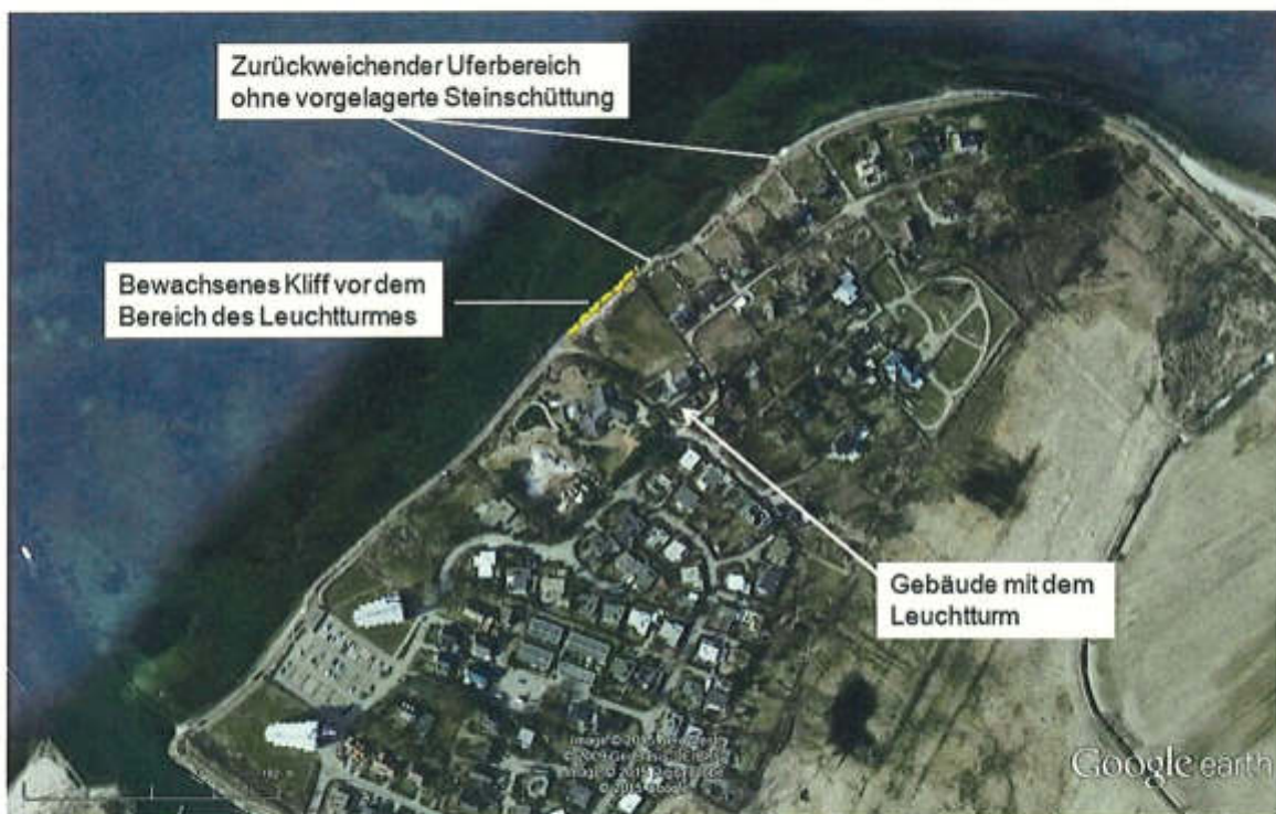
Abbildung 3: Küstenabschnitt zwischen Hafen und Deckwerk. Deutlich ist der zurückweichende Uferbereich zwischen den durch Steinschüttungen gesicherten Uferbereichen und dem Deckwerk zu erkennen (Bildquelle: Google Earth).
