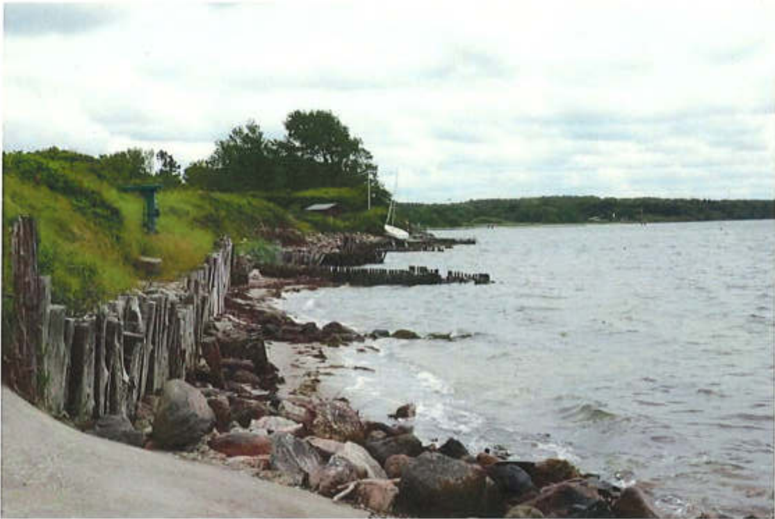
Abb. 4: Individuelle Ufersicherungen südlich des vorhandenen Deckwerkes (Aufnahme: K. Schwarzer).
