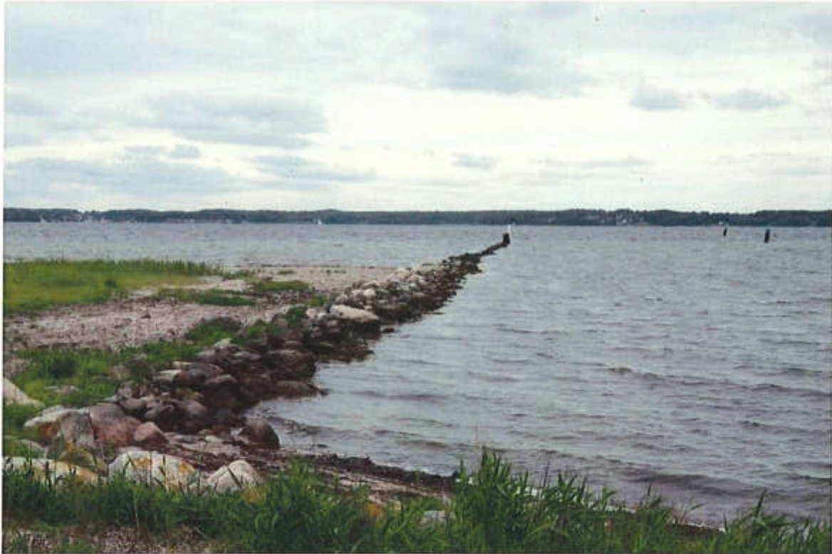
Abb. 5. Sedimentakkumulation an der südlichen Hafenmole (Blickrichtung Norden; Aufnahme: K. Schwarzer, 14.06.2015). Zur Situation an der nördlichen Mole s. Abb. 3.
